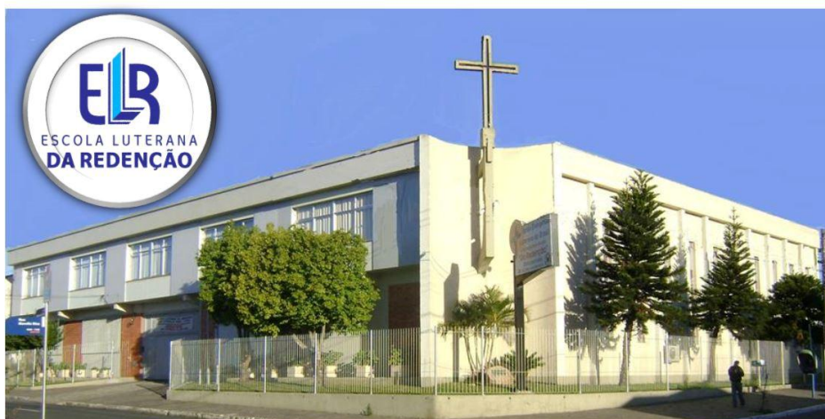
Figura 10: Prédio da Congregação e Escola da Redenção
